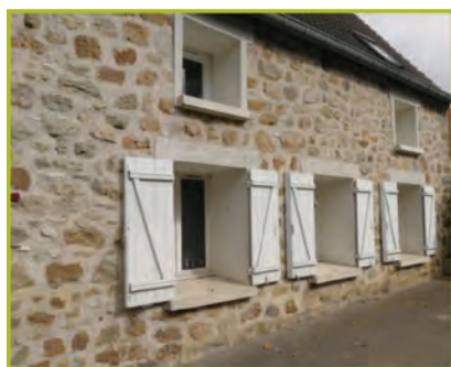
Des portes et fenêtres enfoncées à plus d'une vingtaine de centimètres de la façade (ici plus de 60 centimètres !) créent un effet de façade de « bunker » aussi destructeur pour l'esthétique que pour l'ensoleillement des logements.
