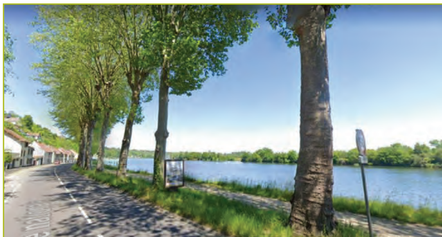
L'alignement de platanes de la RD 133 (ancienne N13) à Rolleboise, élément marqueur du paysage de cette commune.
