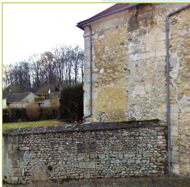
Appareillage de pierres plates ou à profil rectangulaire très régulier dans la vallée de l'Aubette de Magny, enduits ocre-jaune chargés de sablon local (Ambleville, Genainville)
