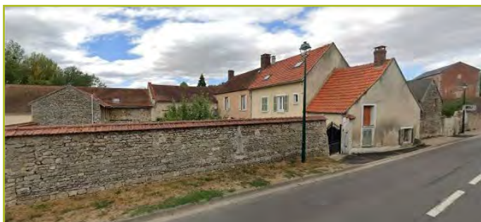
Bâti modeste à Amenucourt : fermettes, lavoir, moulin en briques
