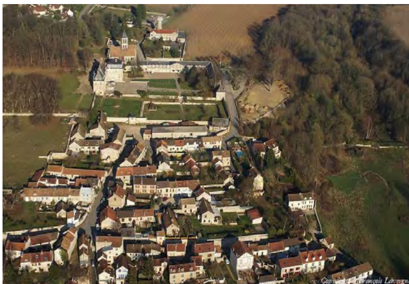
Montgeroult : village bâti sur le versant Nord de la Viosne, avec une implantation majoritairement parallèle aux courbes de niveau (faîtages Est-Ouest). Les façades exposées au Sud sont généreusement ouvertes à l'inverse des façades Nord, presque totalement aveugles. Une conception bioclimatique ancestrale. Crédit photo François Lavergne
