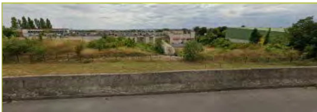
Arrières pas entretenus d'un bâtiment d'activités visible depuis la RD14 au niveau de Vigny
