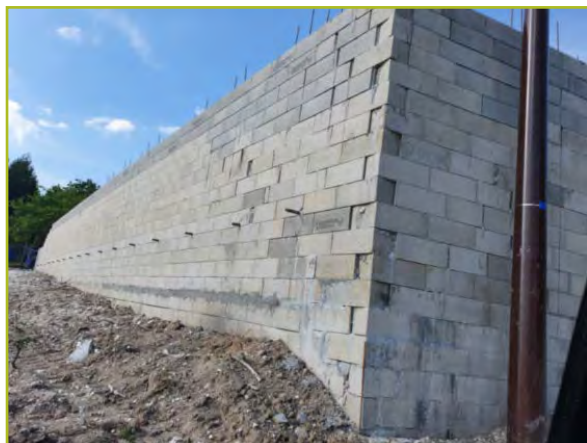
Mur de soutènement de plus de 2 mètres de haut, conséquence de la « mise à plat » d'un terrain en forte pente.
