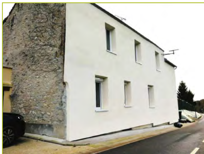
Effet particulièrement banalisant pour le paysage de la mise en place d'une isolation par l'extérieur sur un bâti ancien, avec disparition des modénatures, volets battants remplacés par des volets roulants, mur rendu imperméable (polystyrène).
