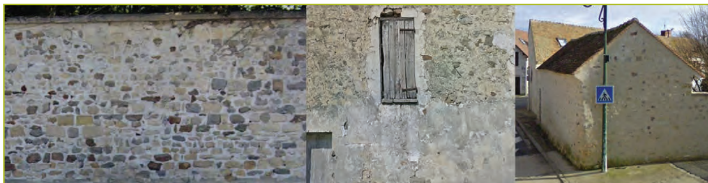
Appareillage mixte de moellons calcaires et grès, et joints au plâtre. Enduits à la chaux usés par le temps.
