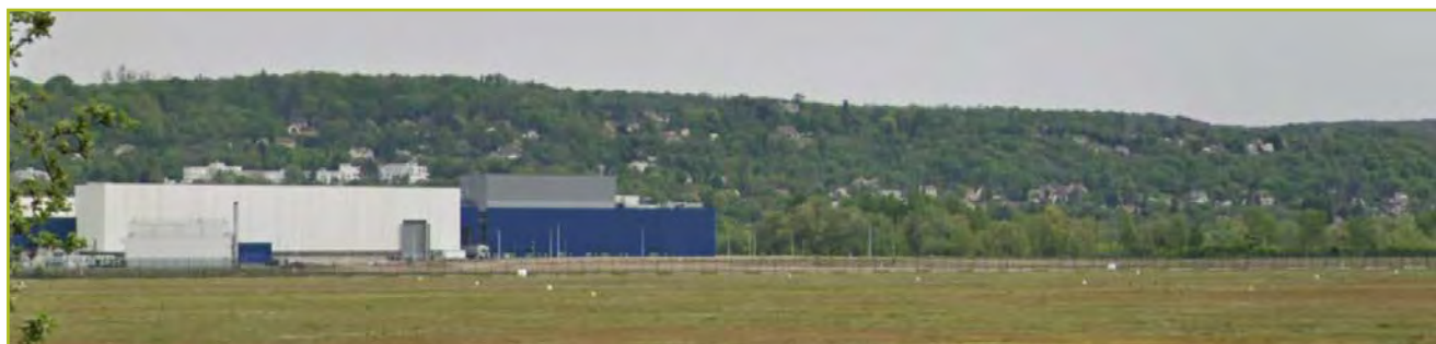
Vue sur le coteau d'Evécquemont, qui ne laisse entrevoir que quelques maisons de maître et la clinique, silhouette blanche qui émerge juste au-dessus des bâtiments de l'Aérospatiale aux Mureaux
