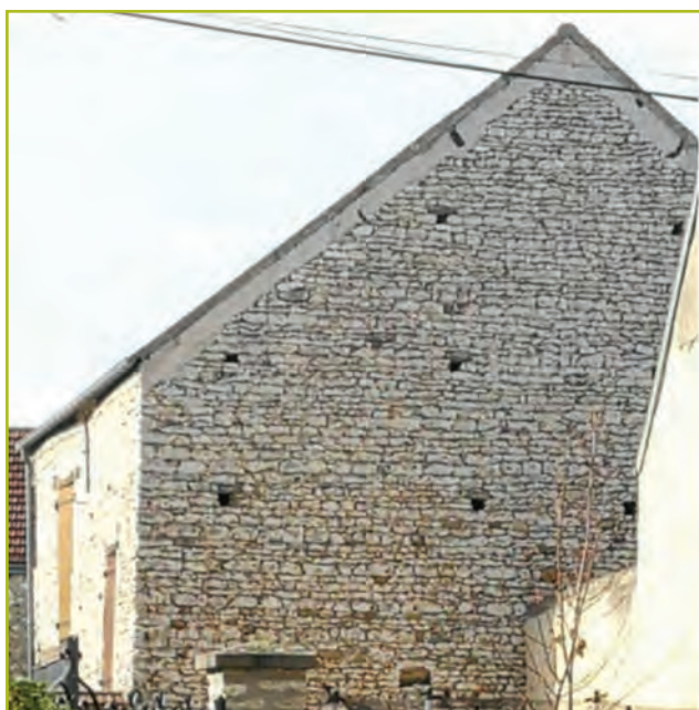
Pignon de grange en moellons réguliers de craie indurée (Guernes)
